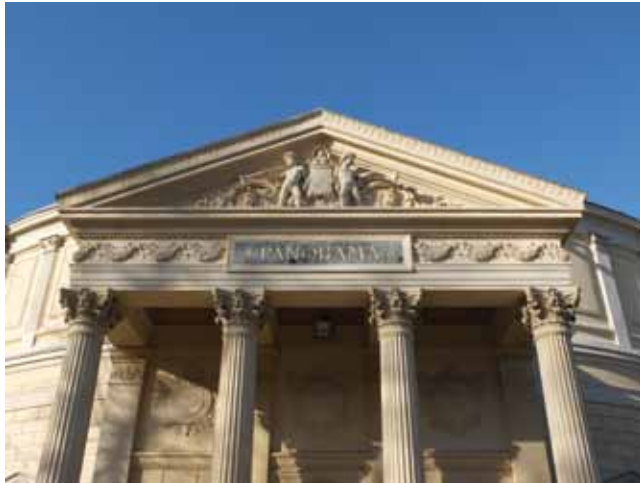
III.5 Paris, le Théâtre du Rond-Point, façade arrière. État en 2012.
